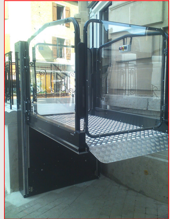
Fig. 1 : Installation pour lieu Public (Portes Automatiques)
