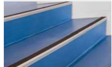
Nez-de-marche avec joint en résine PU
