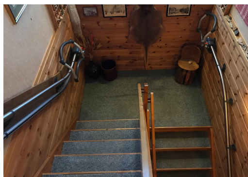
Escalier demi tournant avec palier
