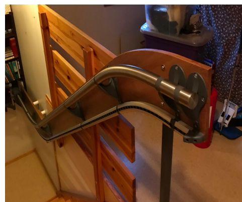
Prolongation de la rampe en haut : à l'aide d'un poteau
